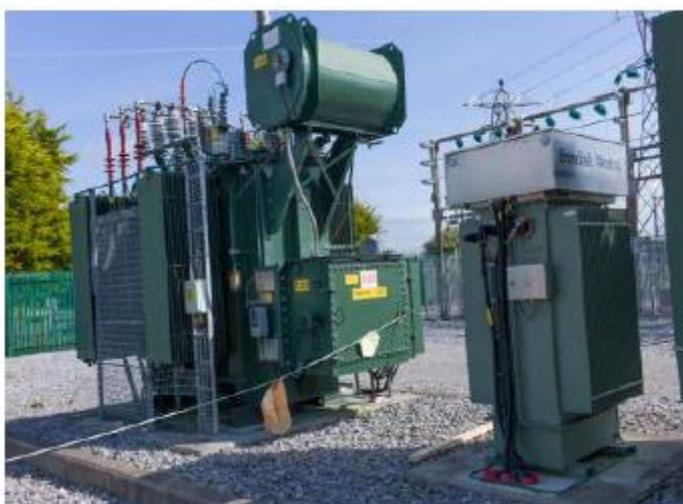
Рисунок 2: Современная быстро настраиваемая дугогасительная катушка со сплошным сердечником (справа на фотографии) образует высоковольтную часть системы GFN.
