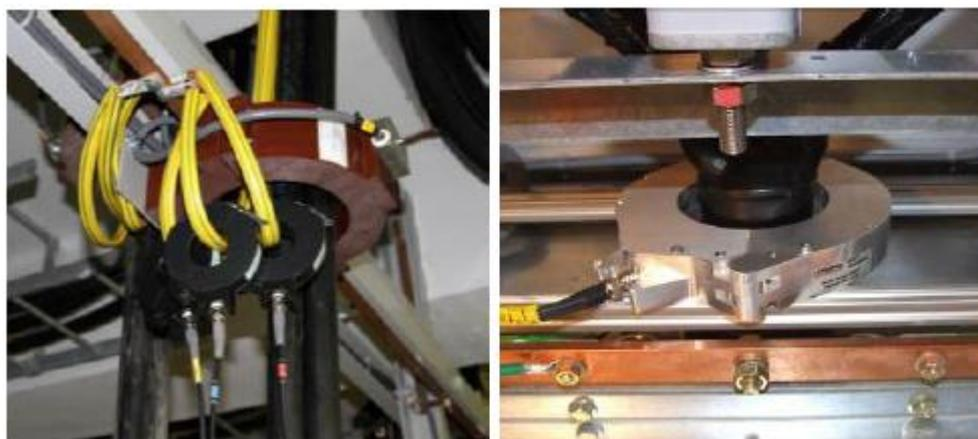
Рисунок 5: Примеры подсоединения датчиков НФСТ.
