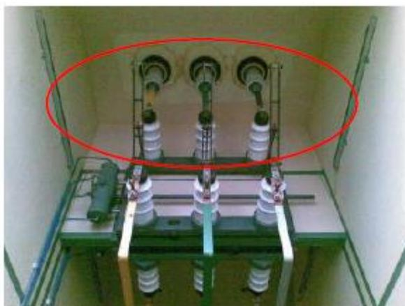
Рисунок 10 Доказательства попадания воды на вводах распределительного устройства.
