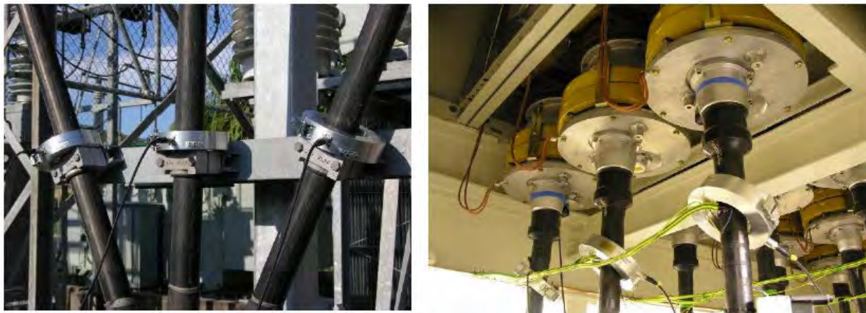
Рисунок 3: Примеры подсоединения датчика HFCT с разъемным сердечником к жиле кабеля XLPE.
