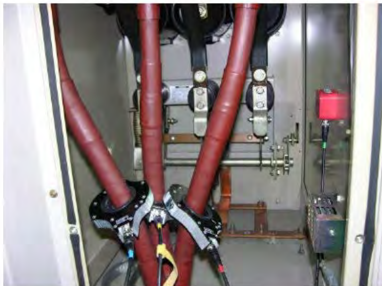
Рисунок 4: Установка трех датчиков HFCT вокруг каждой из фаз кабеля XLPE 11 кВ после снятия напряжения и обеспечения безопасности распределительного устройства.
