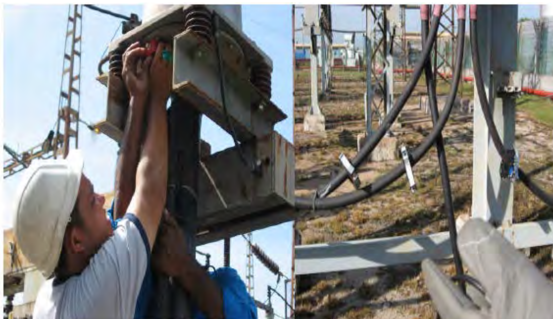
Закрепление датчика HFCT на заделанных концах уличного кабеля.
