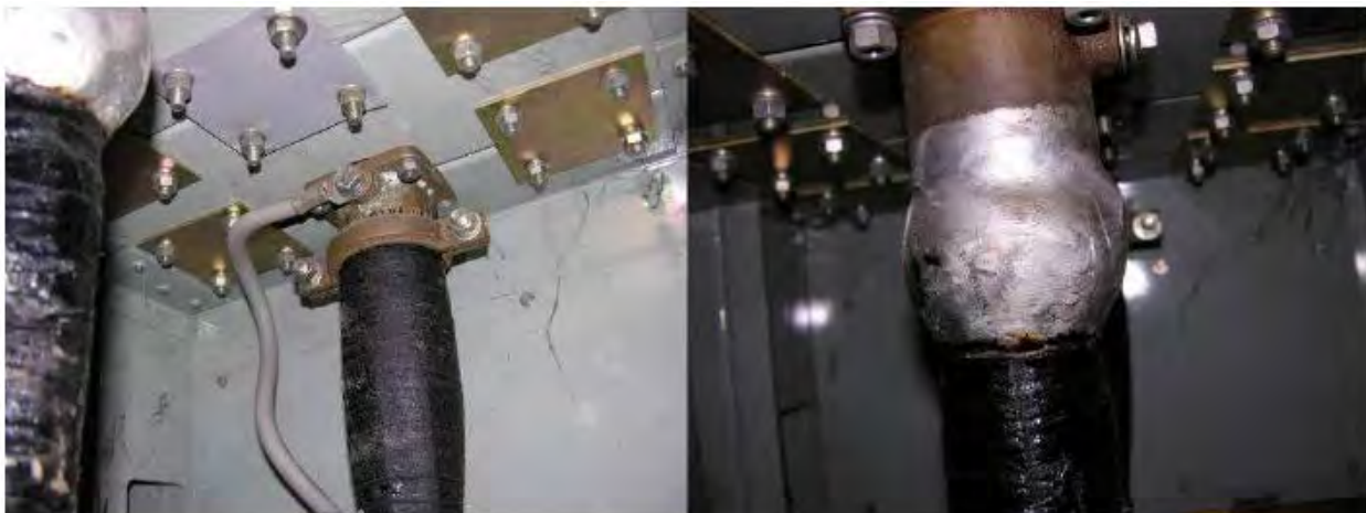
Рис. 2б. Концевая заделка кабеля PILC, не подходящая для тестирования частичного разряда в рабочем режиме. (Слева жесткое соединение между землей кабеля и распределительным устройством, справа – уплотнитель, покрытый свинцом.)
