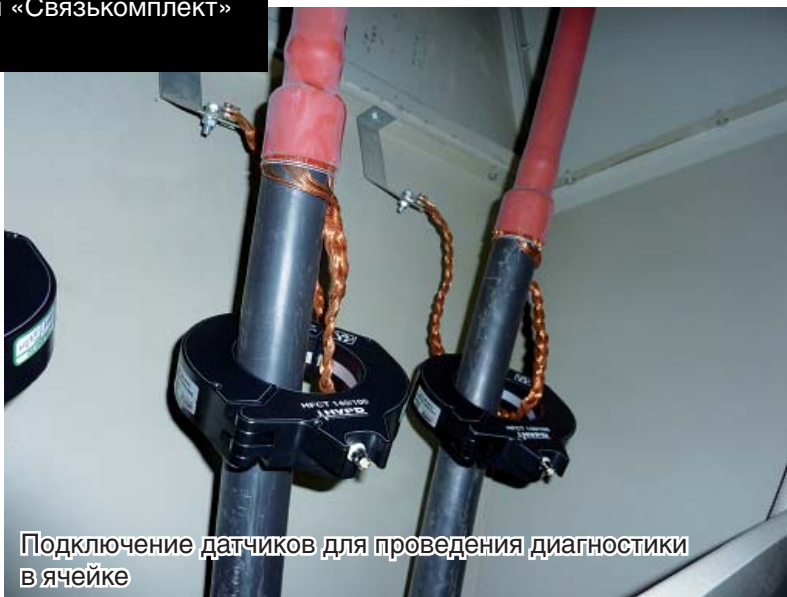
Подключение датчиков для проведения диагностики на стороне трансформатора
