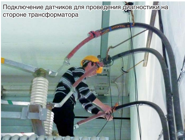
Подключение датчиков для проведения диагностики в ячейке
